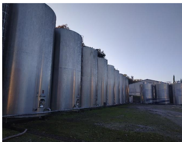
Photo n° 2 : Les cuves de 1245 de 1245 hl
